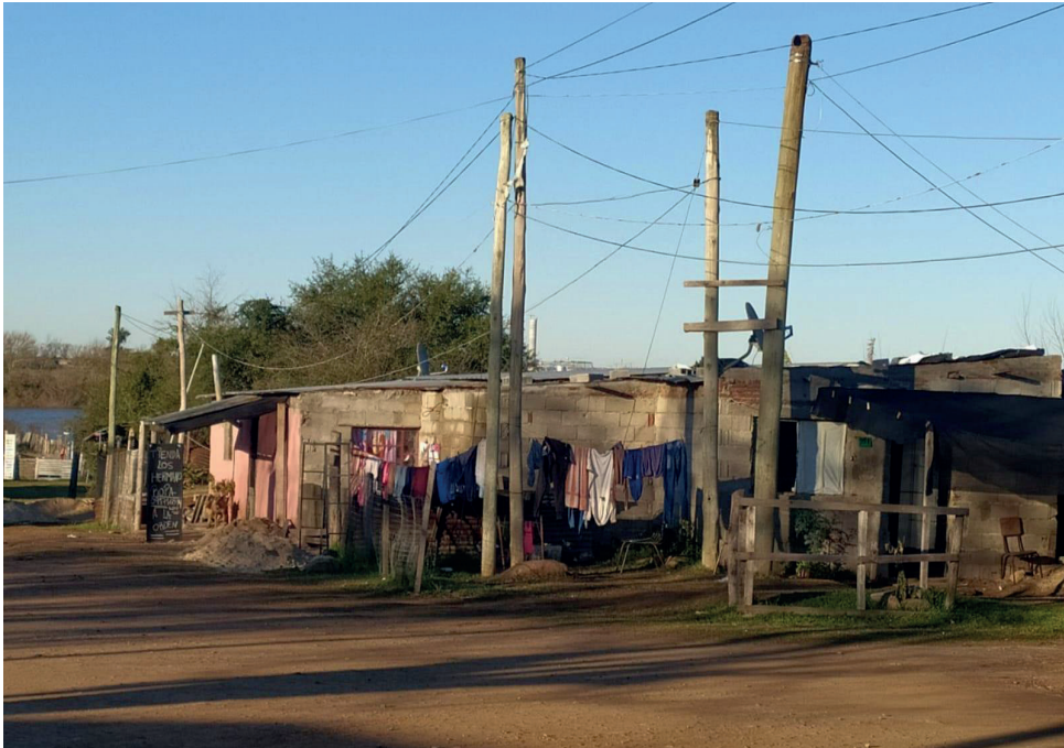
Figura N° 3- Asentamientos irregulares de viviendas por debajo de la "cota 60", tendido eléctrico "colgado" de cables principales.
